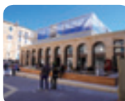
街と調和するはちみつ色の外観
